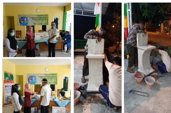
Gambar 5. Serah Terima Peralatan Kesehatan & Pemasangan Washtafel Cuci Tangan Permanen
