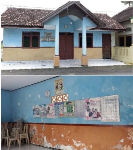
Gambar 4. Kondisi Posyandu Sebelum Pengecatan
