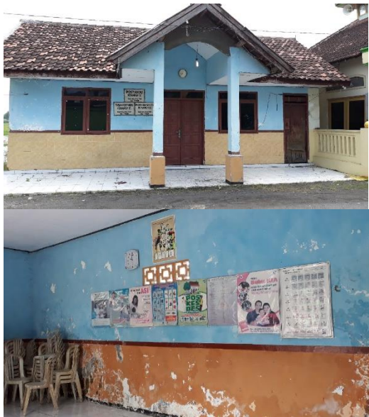
Gambar 4. Kondisi Posyandu Sebelum Pengecatan
