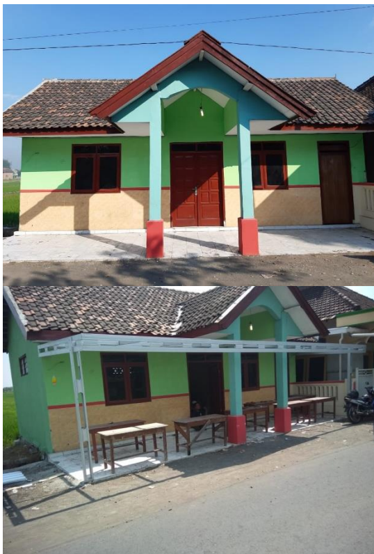
Gambar 5. Kondisi Posyandu setelah Pengecatan dan Pemasangan Atap Teras dengan Galvalume
