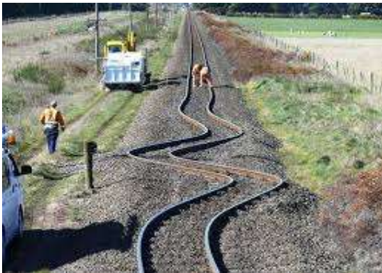
Gambar 9. Rel melengkung dan sambungan dibuat berjarak (www.google.com)
