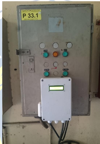
Gambar 4.2 Pemasangan Alat pada Panel kontrol Overhead Crane
