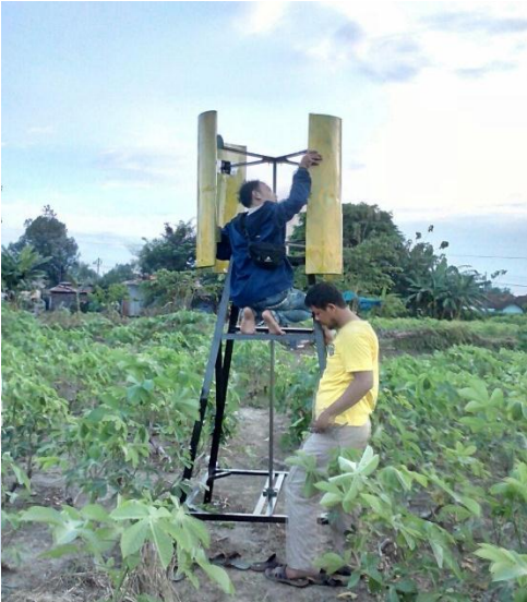
Proses Pemasangan Turbin
