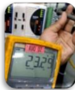
Gambar 11. Pengukuran Arus I/O Module dan Pressure Switch
