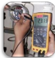
Gambar 9. Pengukuran Tegangan Pressure Switch
