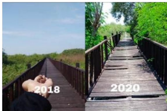
Figure 2. Jembatan di Pulau Lusi Penulis tahun 2020
